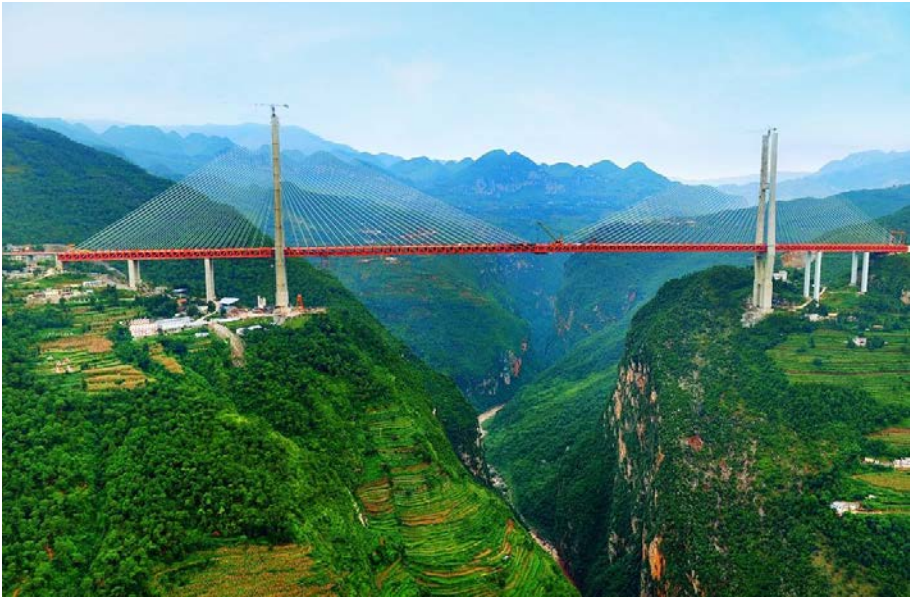
Beipanjiang-Brücke in China, mit 565 m Höhe derzeit die höchste Brücke der Welt
